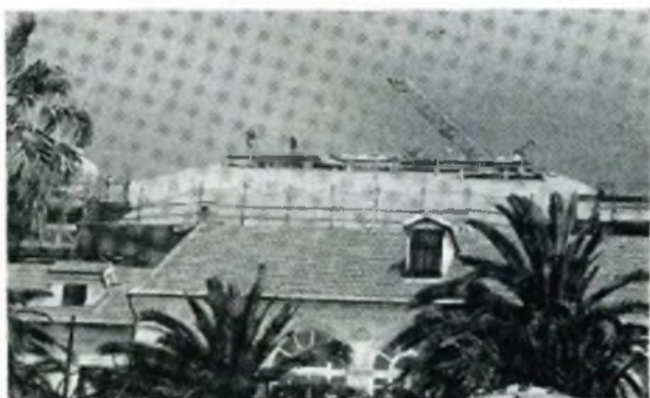
« Basilica S. Nicolò » falda a mare copertura del tetto ultimata
