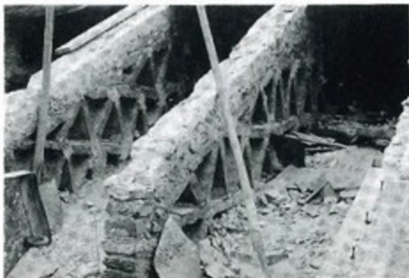
« Basilica S. Nicolò » falda a monte muretti « a castello di carte strutturali » pulizia dei detriti accumulati nel 1950.
