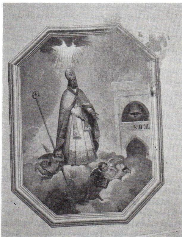
Soffitto deteriorato da infiltrazioni d'acqua meteorica proveniente dalle coperture.
