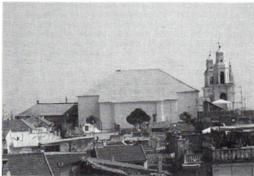
Tetto Basilica S. Nicolò restaurato e 2 delle 4 nuove finestre.
